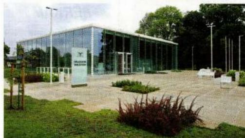
Modernā ēka veidota no taisna un liekta tērauda fasāžu sistēmas. Lai ēka būtu energoelefktīva, izmantotas trīs stikla paketes ar saules siltumu un iekšelpu enerģiju atstarojošiem slānjiem.
